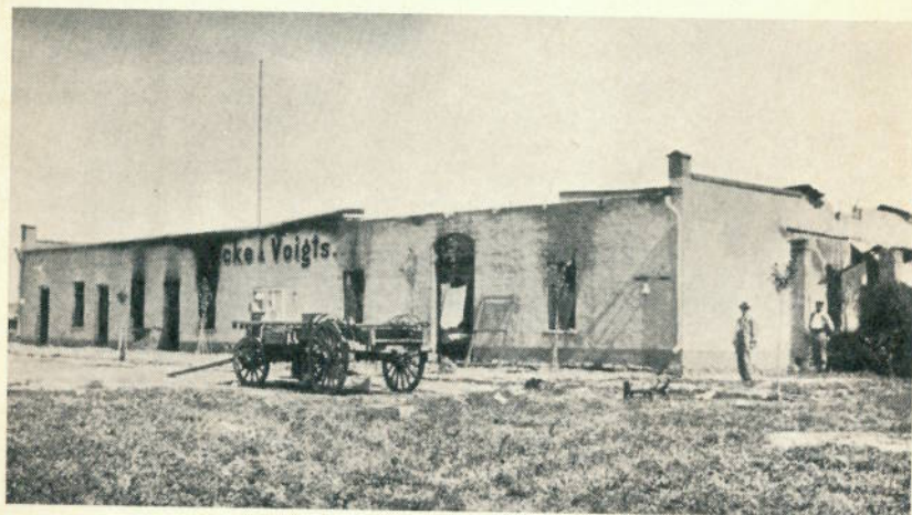
Geschäftshaus der Firma Wecke & Voigts nach der Zerstörung durch die Hereros am 12. Januar 1904 (Staatsarchiv Windhoek)
